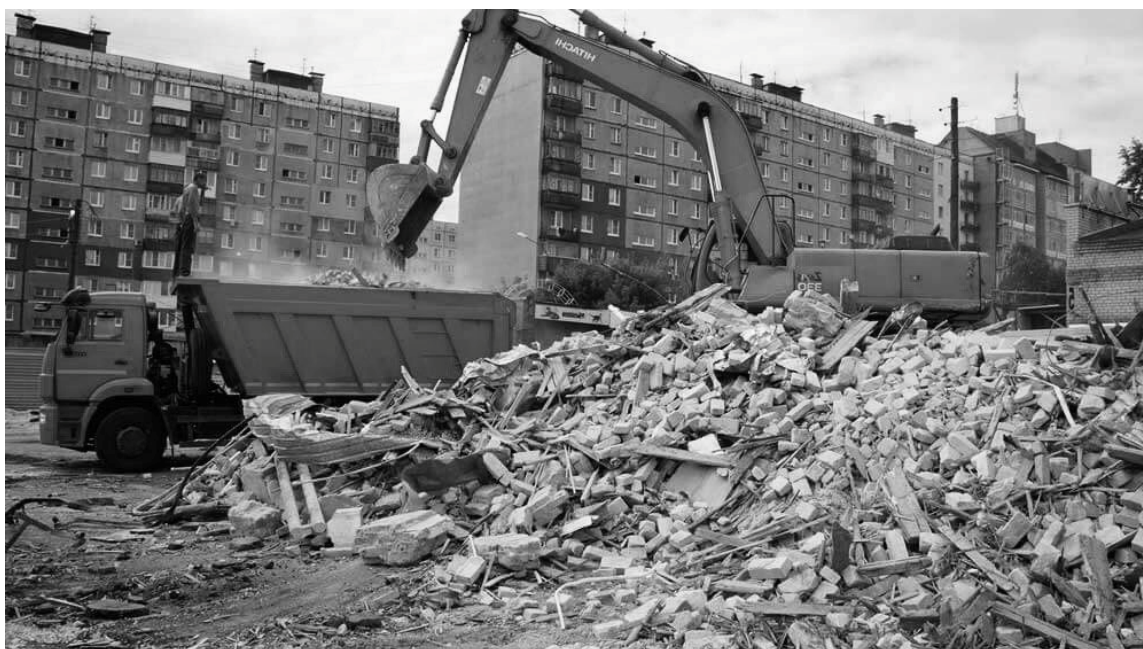
Рис.2. Вывоз строительного мусора строительной техникой
